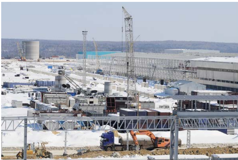
Рис. 4.7. Строительная площадка Богучанского алюминиевого завода
