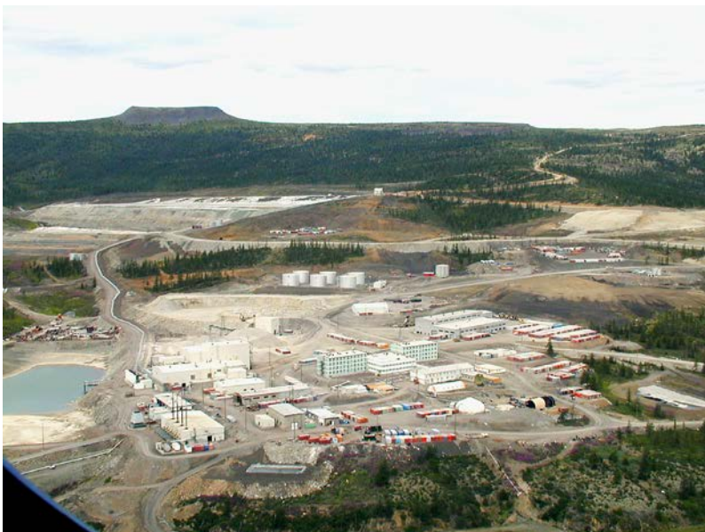
Рис. 6. Кубакинский ГОК: эксплуатация Омолонского группового проекта осуществляется на мощном современном обогатительном комплексе (фотография предоставлена А. Косовым)
